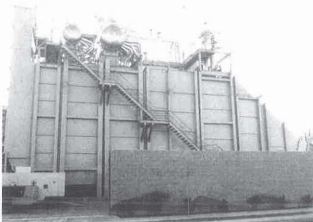
Fig. 9 HRSG with SCR.
